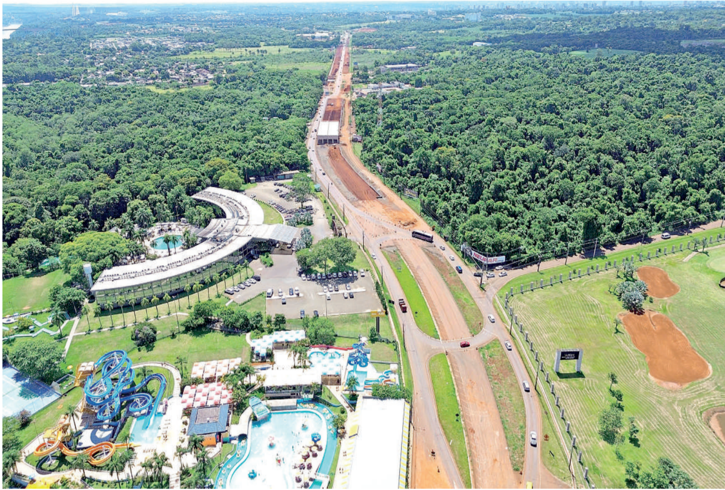
Projeto de duplicação tem várias falhas executivas que atrasam o andamento da obra DER/PR
